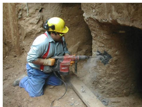
Bild 11 : Herstellen der Prüfmöglichkeit bei zerstörungsfreier Pfahlprüfung
