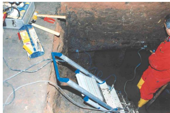
Bild 4 : Messtrecke am Horizontalbalken
