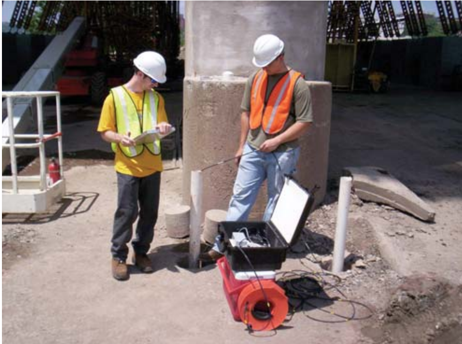
Bild 4: Induktivmessungen in PVC verrohrten Bohrlöchern
