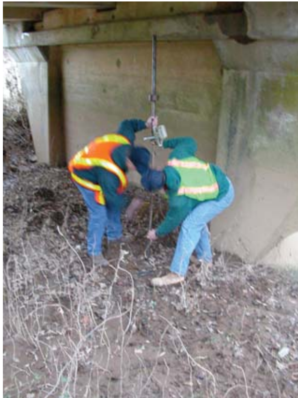
Bild 1: Einsatz einer leichten Rammsonde unter einer Brücke
