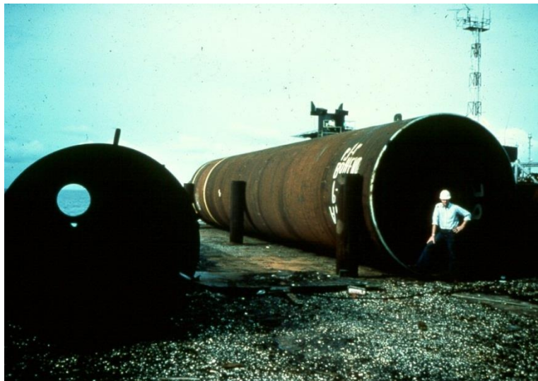
Abbildung 1: Rohrpfahl von 3660 mm Durchmesser vor der Rammung
